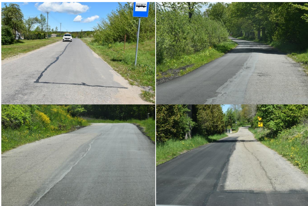
Zdjęcie. 14. Remonty częściowe nawierzchni bitumicznych.
