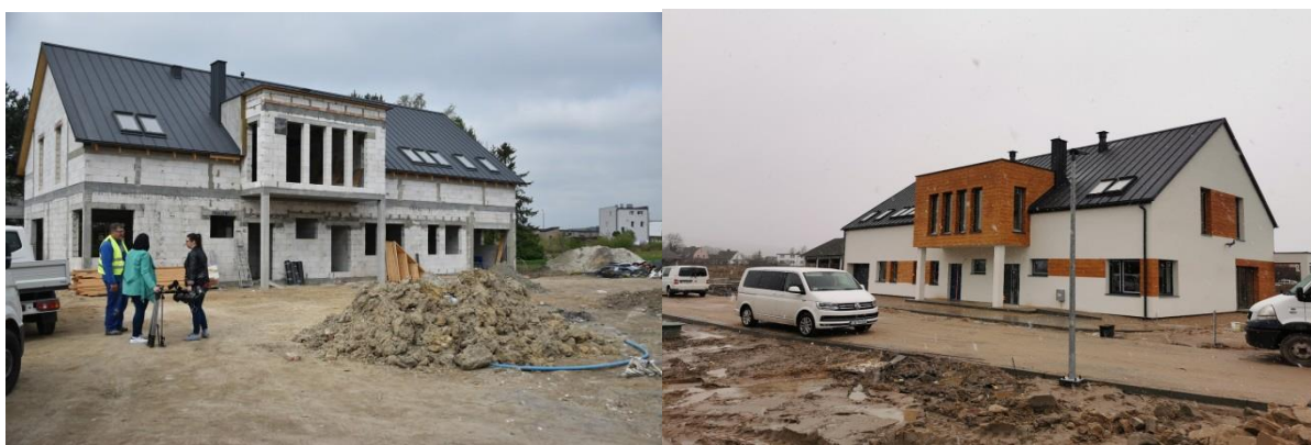
Zdjęcie. 15. Plac budowy w trakcie realizacji inwestycji.
