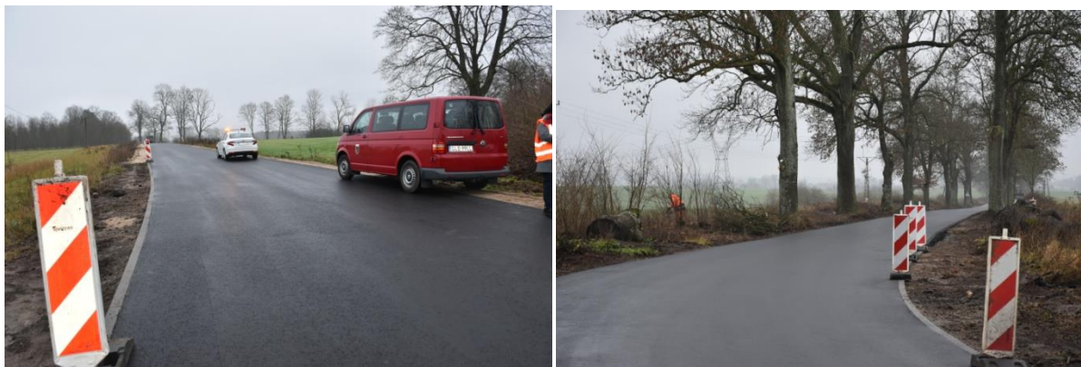
Zdjęcie. 16. Zakończenie pierwszego etapu budowy drogi powiatowej 1309G i 1311G do Janowic.
