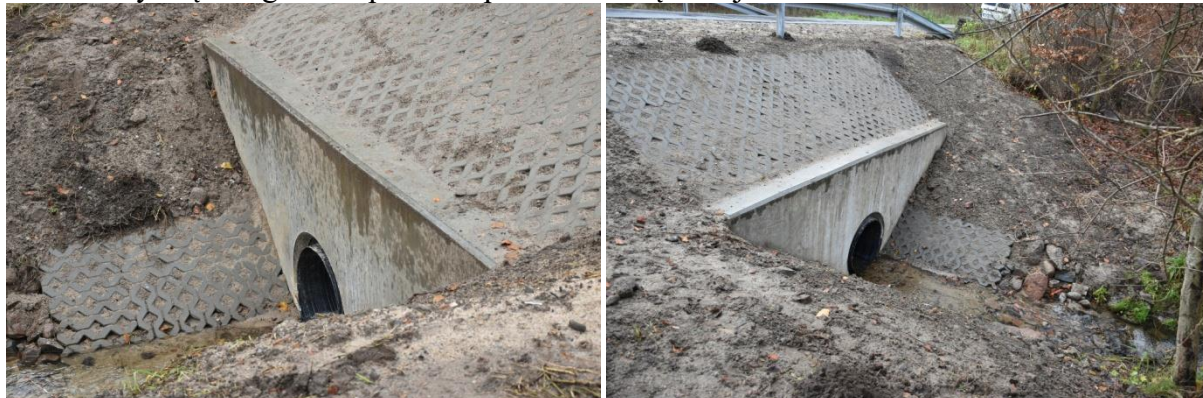
Zdjęcie. 12. Przepust w Obliwicach.
