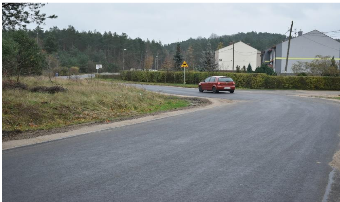
Zdjęcie 13. Droga do Dziechlina po przebudowie
