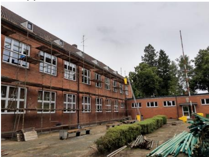
Zdjęcie 28. Prace budowlane na dachu ZSO nr 2 w Lęborku
