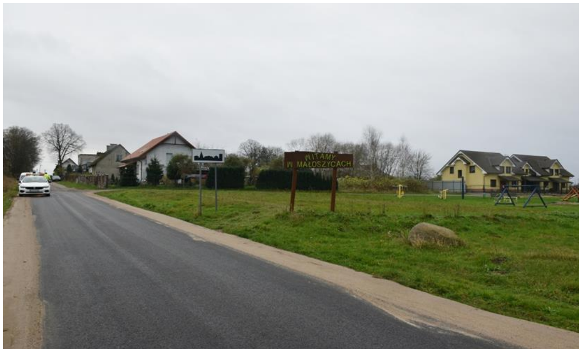
Zdjęcie 12. Przebudowana droga na wjeździe do miejscowości Małoszyc
