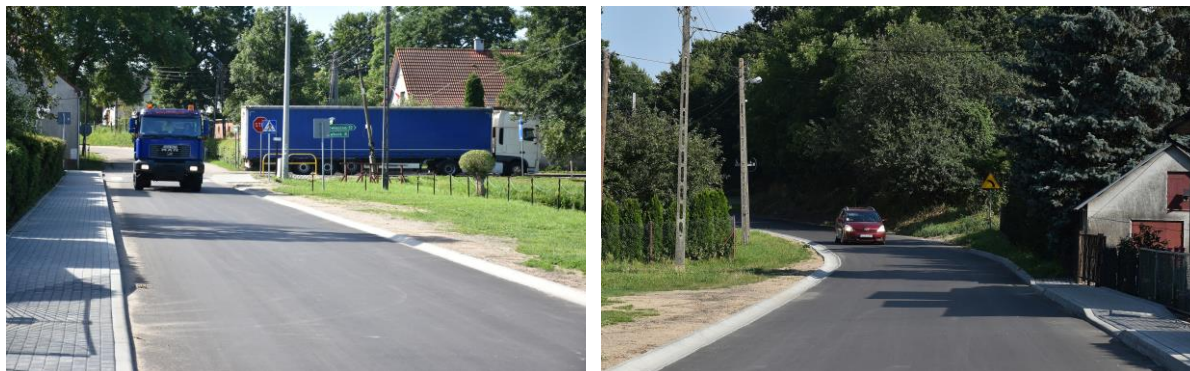
Zdjęcie 12 i 13. Skrzyżowanie w miejscowości. Redkowice i fragment przebudowanej drogi do Janowiczek
