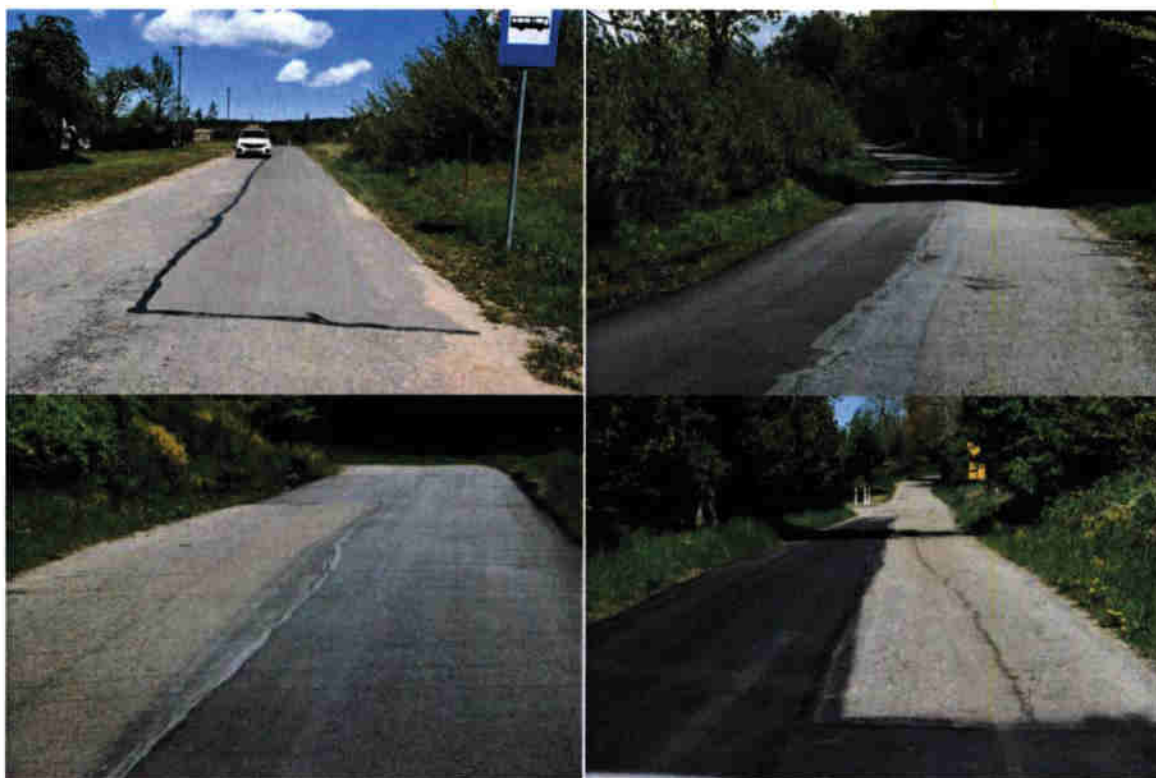
Zdjęcie. 14. Remonty częściowe nawierzchni bitumicznych.
