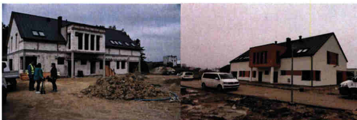
Zdjęcie. 15. Plac budowy w trakcie realizacji inwestycji.
