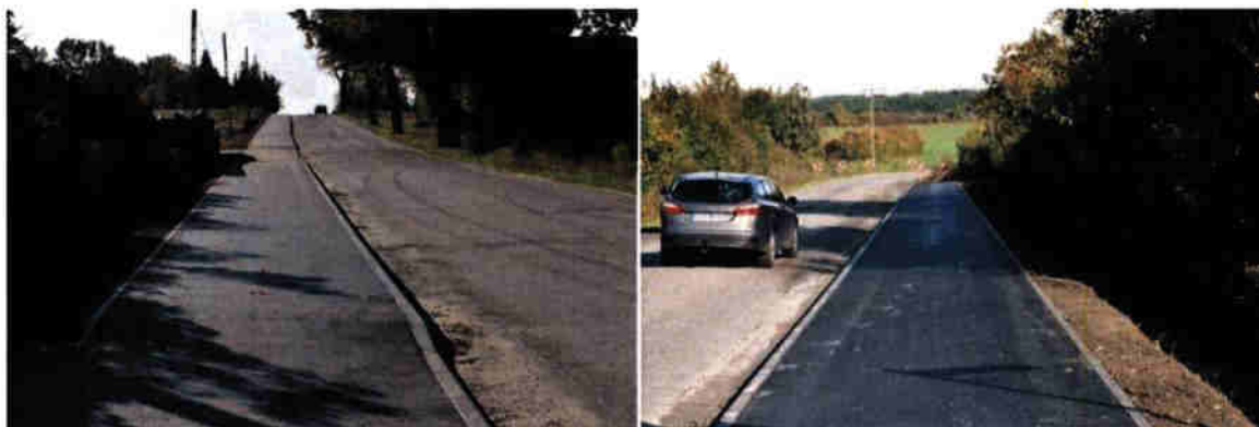
Zdjęcie. 8. Nowy ciąg pieszo rowerowy przy ul. Kębłowskiej.
