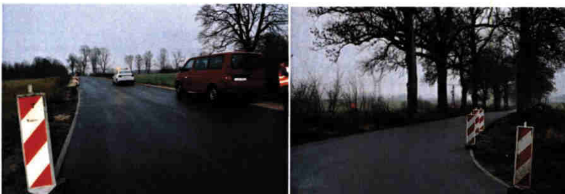
Zdjęcie. 16. Zakończenie pierwszego etapu budowy drogi powiatowej 1309G i 1311G do Janowic.
