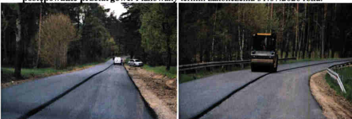
Zdjęcie. 17. Prace budowlane na drodze powiatowej nr 1336G od km 4+000 do granicy powiatu lęborskiego km 6+552.
