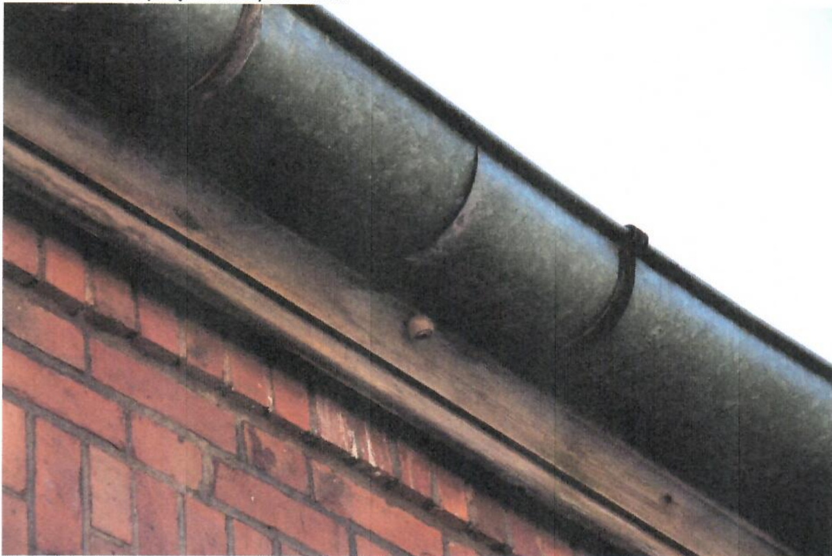
10. Wadliwe połączenie orynnowania
