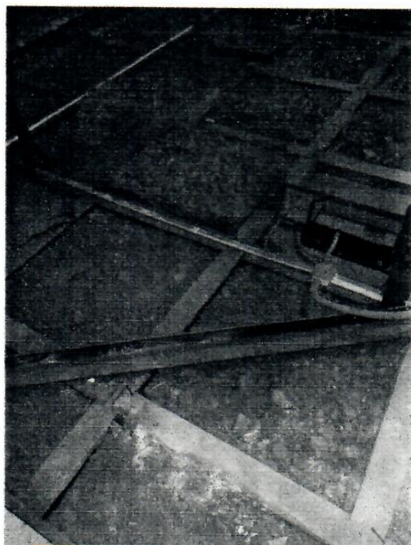
Fotografia Nr 5 konstrukcja sufitu z kasetonami wypełnionymi mieszanką z gliny – miejsce zainstalowania lampy w kasetonie
