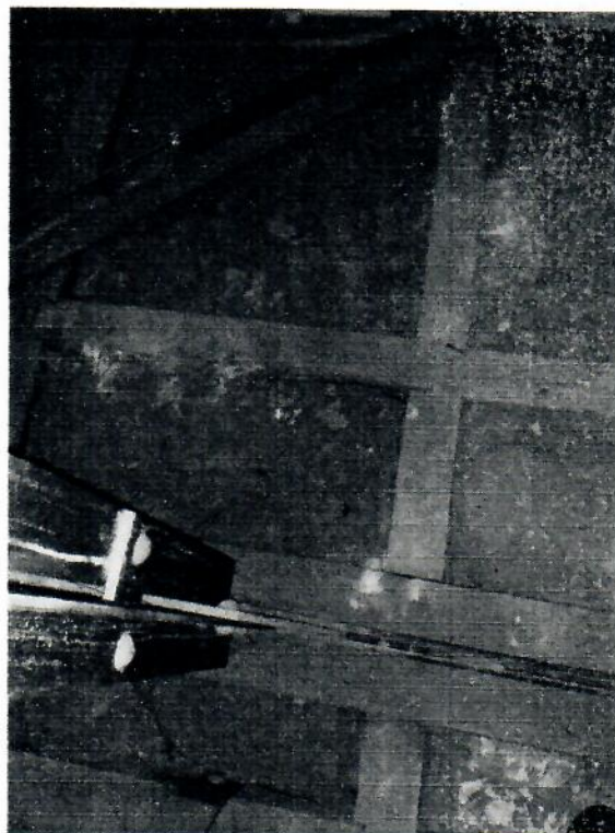
Fotografia Nr 5 konstrukcja sufitu z kasetonami wypełnionymi mieszanką z gliny – miejsce zainstalowania lampy w kasetonie
