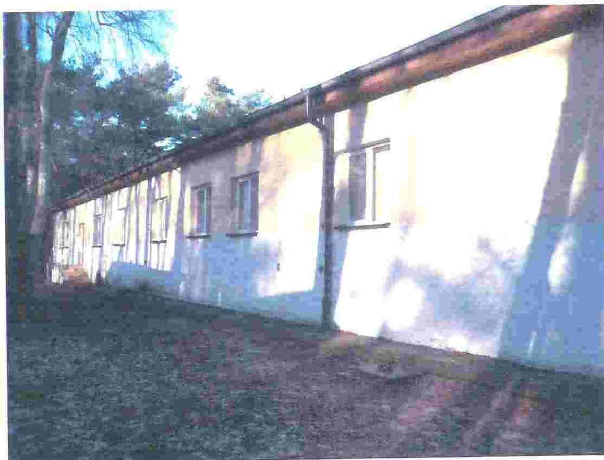
Budynek hotelowy - widok od strony południowej.
