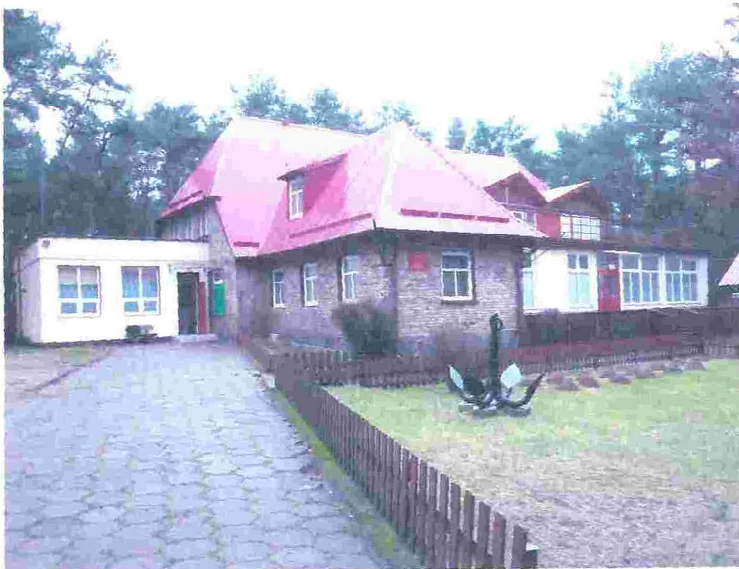
Budynek schroniska - widok od strony południowej.
