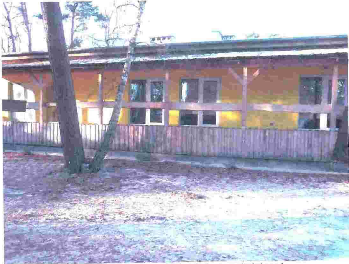
Budynek hotelowy - widok od strony południowej.
