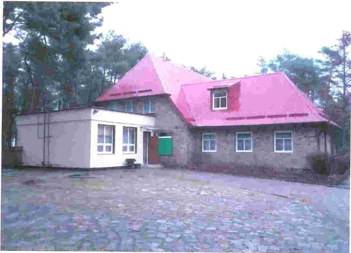
Budynek schroniska - widok od strony południowej.
