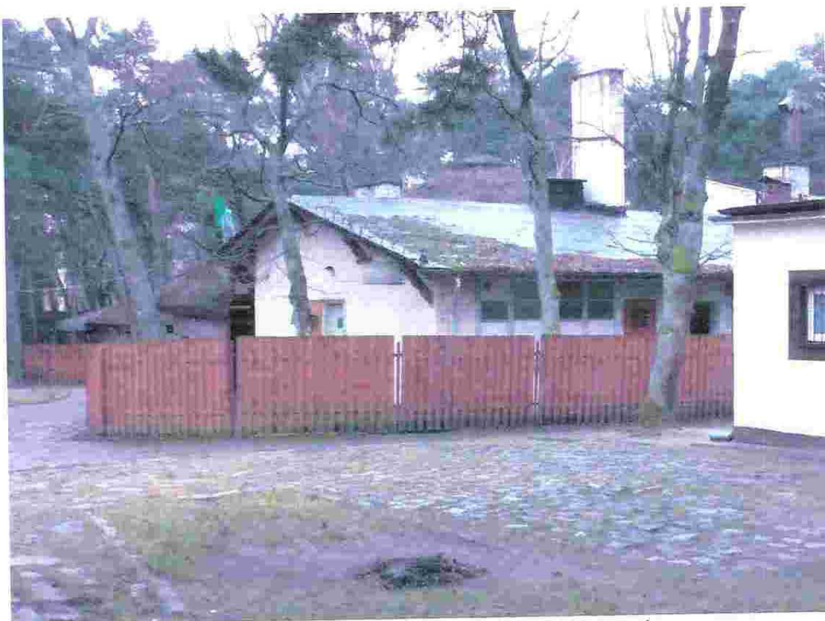
Budynek hotelowy - widok od strony północnej.
