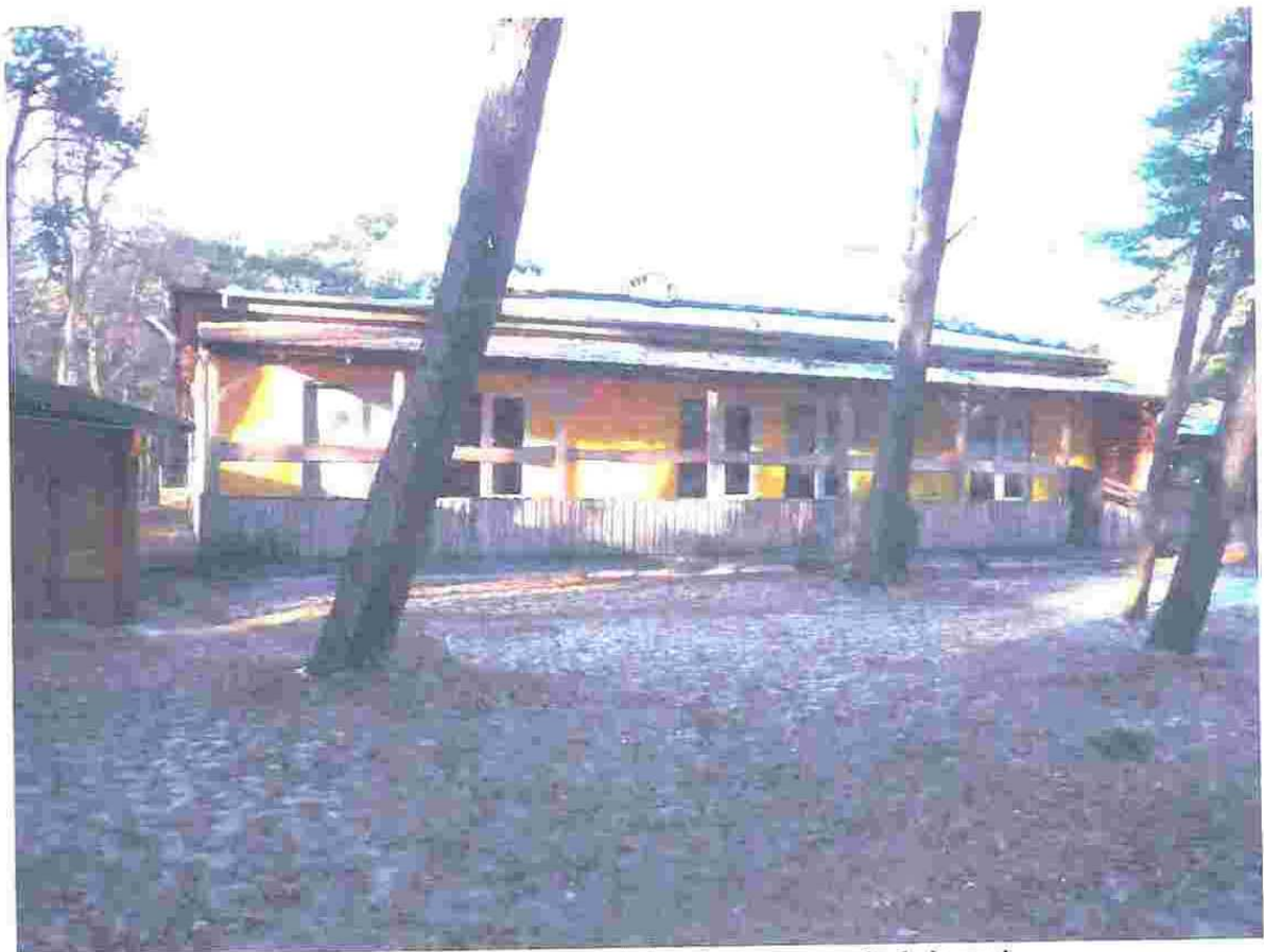
Budynek hotelowy - widok od strony południowej.
