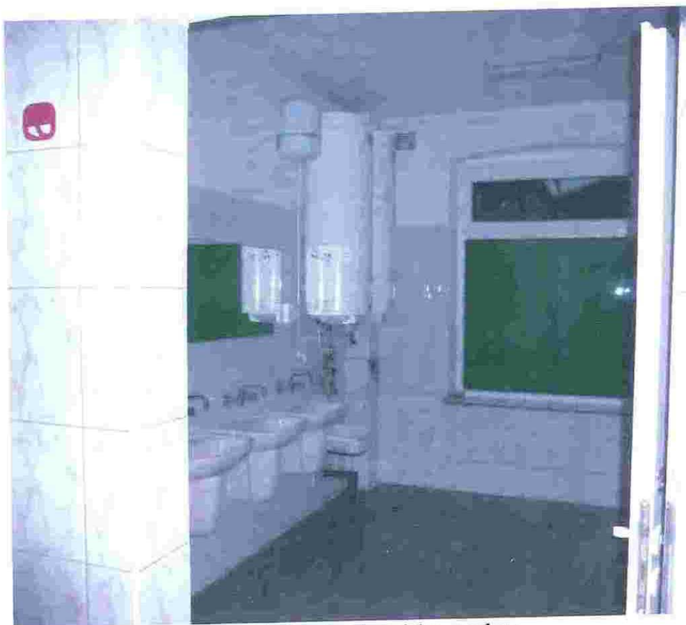
Budynek schroniska - toalety.
