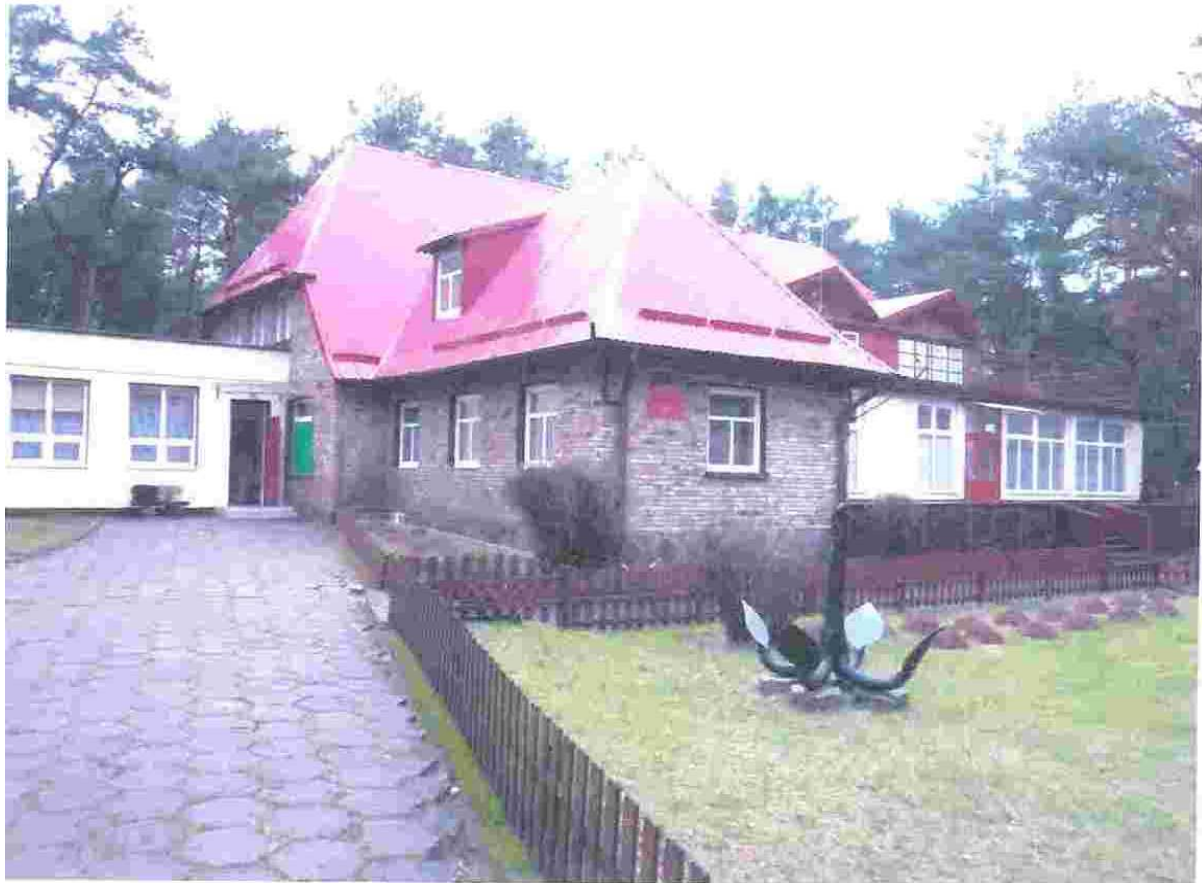
Budynek schroniska - widok od strony południowej.
